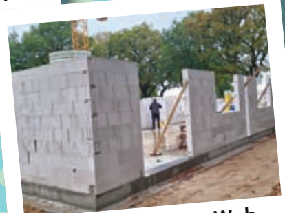
WoDi baut: 10 neue Wohnungen in Ostrohe.
