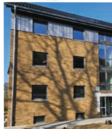
Alles neu auch in der Vollma- büttel nach der Sanierung.
